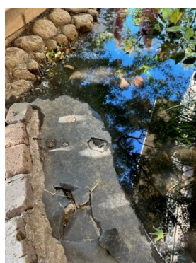
シートが破れ、泥や砂で水深が浅くなっている
