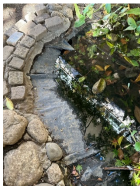
シートが破れ、泥や砂で水深が浅くなっている
